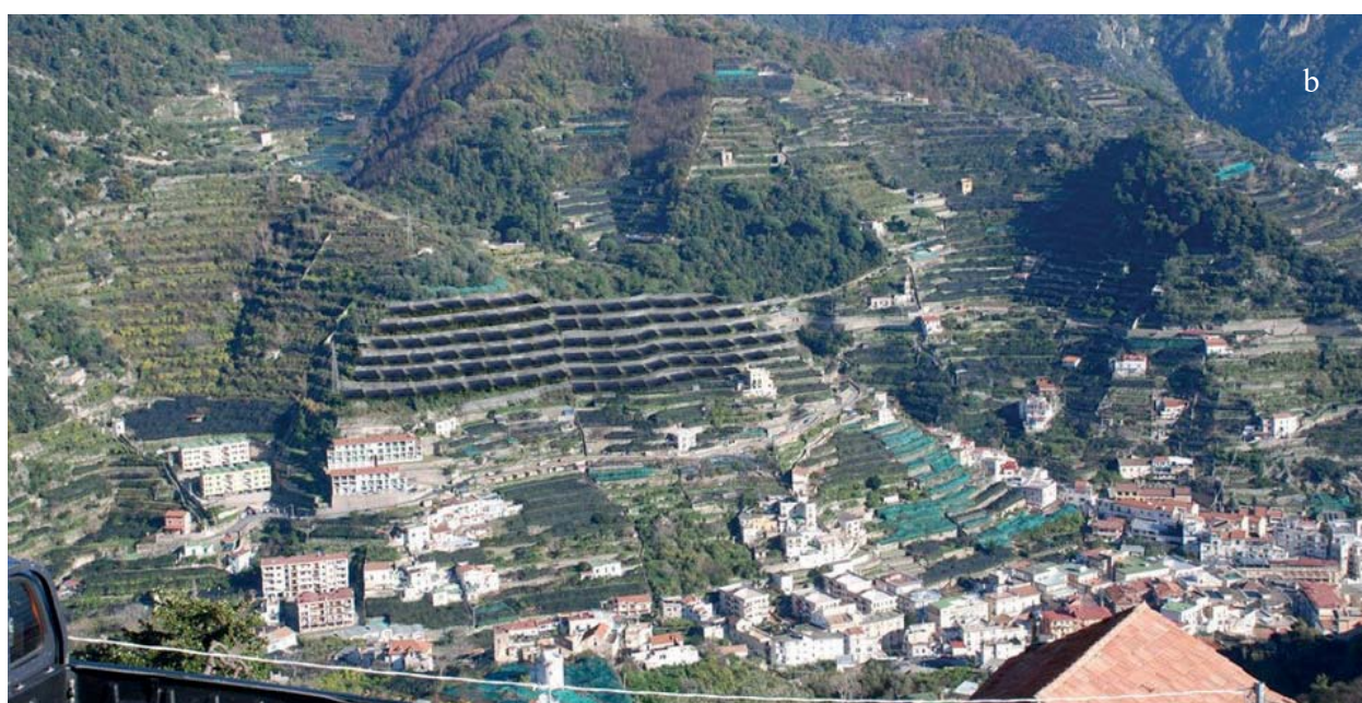
A5.9 - Se le serre vengono addossate ai muri e non occupano l'intera terrazza (a) possono essere considerati un intervento di "restauro del paesaggio", più corretto delle reti in plastica visibili sulla sinistra. Pannelli fotovoltaici appoggiati a terra (b) possono ripristinare il grafismo delle terrazze, cancellato dalla vegetazione spontanea (in alto al centro) o profondamente alterato dalle reti in plastica (in basso a destra, tra le case).
