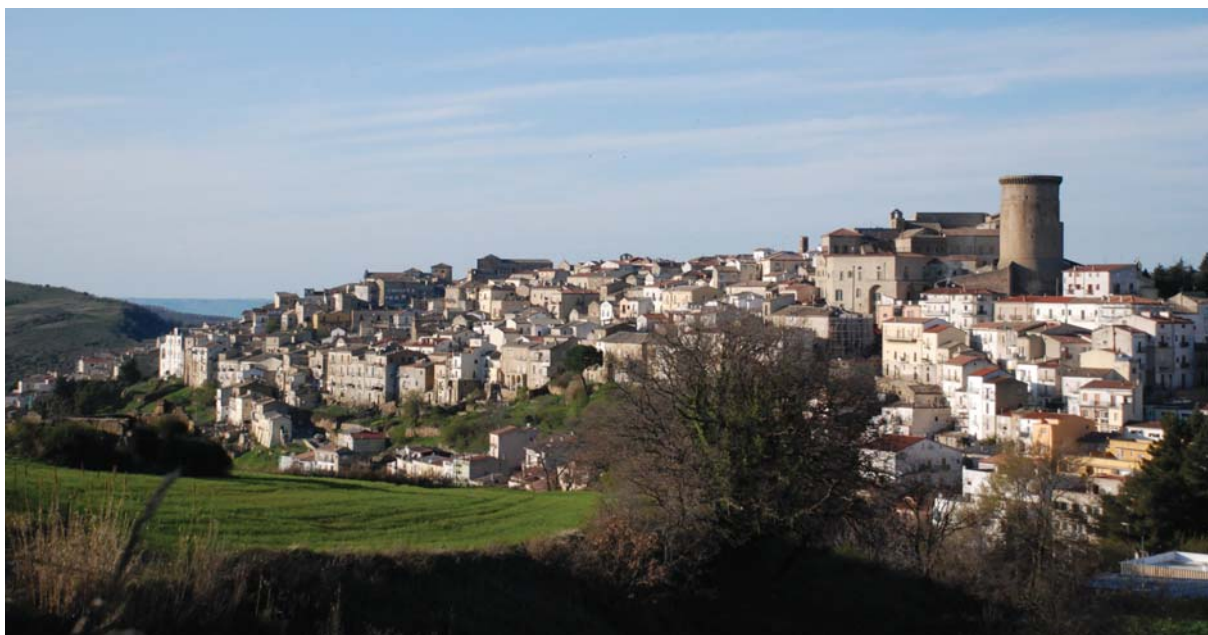
4.1. - Il torrione ha scala e tessitura muraria nettamente diverse da quelle dell'edificato antico circostante. Ma è un elemento "forte" del paesaggio.
