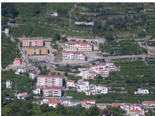
4.2. - Gli edifici in secondo piano sono interventi di edilizia pubblica, volumi, altezze e colori sono totalmente conformi alle norme urbanistiche, ma la dissonanza con l'edificato antico circostante è evidente.
